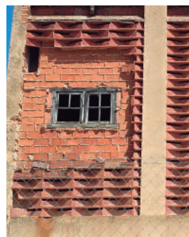
Sistema atípic de façana ventilada. St Feliu Guíxols. Font propia
