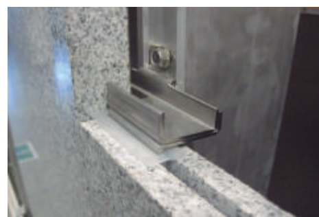
Sistema Masa, ancoratges ocults per natural. Font pròpia
