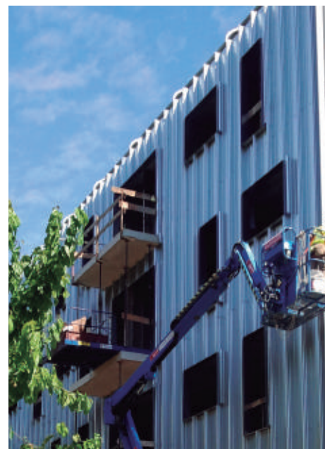
Habitatges socials a Gavà. PichArchitects. Font PichArchitects. Figura 36 -. Muntatge del full interior Eurohabitat - Siff®. Font PichArchitects
