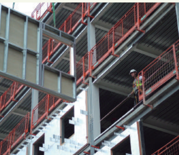
Muntatge de panells lleugers per façana ventilada. Font Kingspan Architectural
