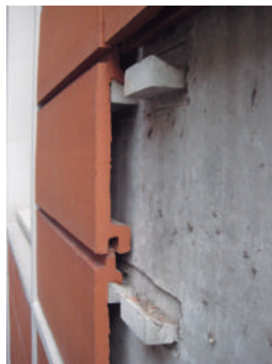
Mensules de suport del full exterior. Habitatges a la rue de Meaux de Paris . Font pròpia
