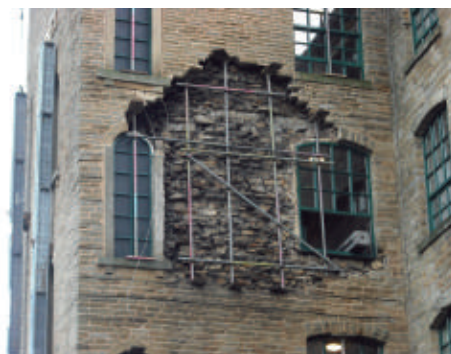
Desvinculació del full exterior. Font https://www.helifix.co.uk/
