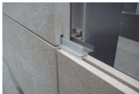
Trencament del full exterior per dilatació tèrmica de l'ancoratge. Font pròpia
