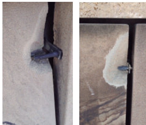
Trencament del full exterior per dilatació tèrmica de l'ancoratge. Font pròpia
