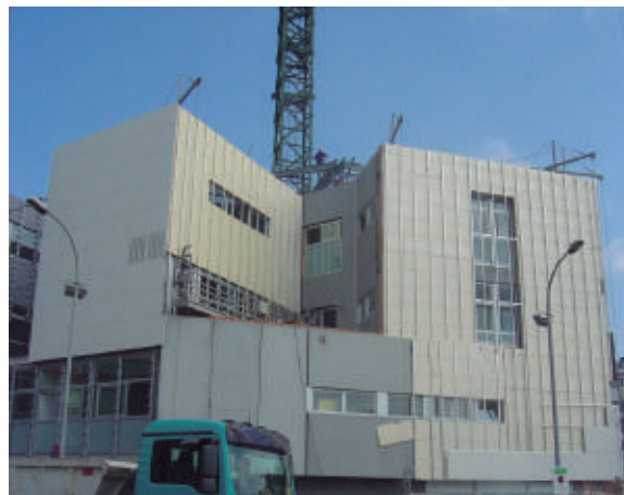
Muntatge de la subestructura d'entramat pel full exterior. Font PichArchitects
