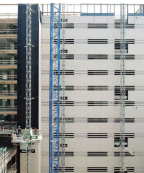
Fases de muntatge de la façana. Hotel Drassanes. Font Sistema Masa i Seccio detall façana, a la dreta.
