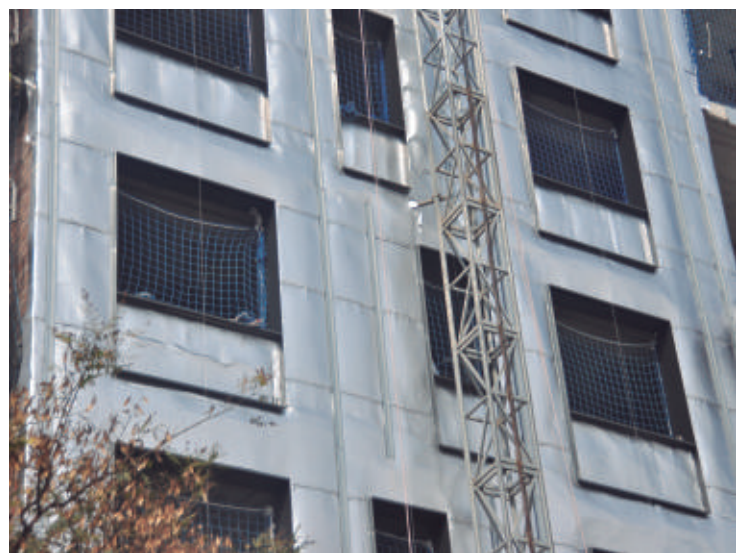
Aïllament tèrmic tipus reflexiu. GCT Arquitectes Font pròpia
