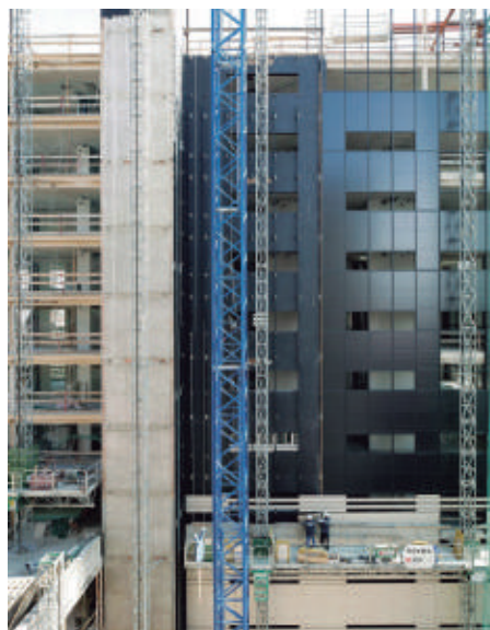
Fases de muntatge de la façana. Hotel Drassanes. Font Sistema Masa i Seccio detall façana, a la dreta.
