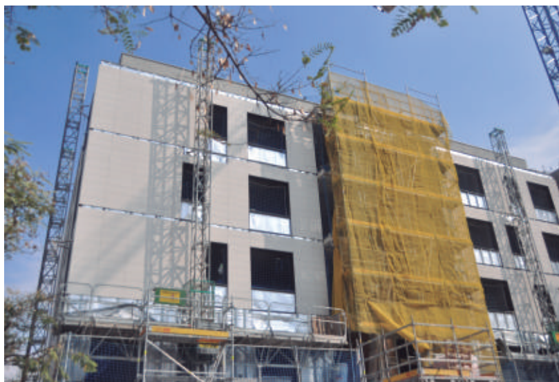
Habitatges al carrer de Ramon Llull, de Sant Adrià de Besòs. GCT Arquitectes. Font pròpia
