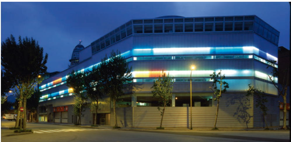
Rehabilitación integral de un edificio industrial 22@. Barcelona. 2004
