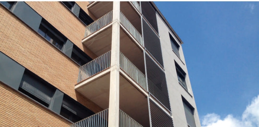
Edificio de viviendas. Sant Cugat del Vallès. 2016
