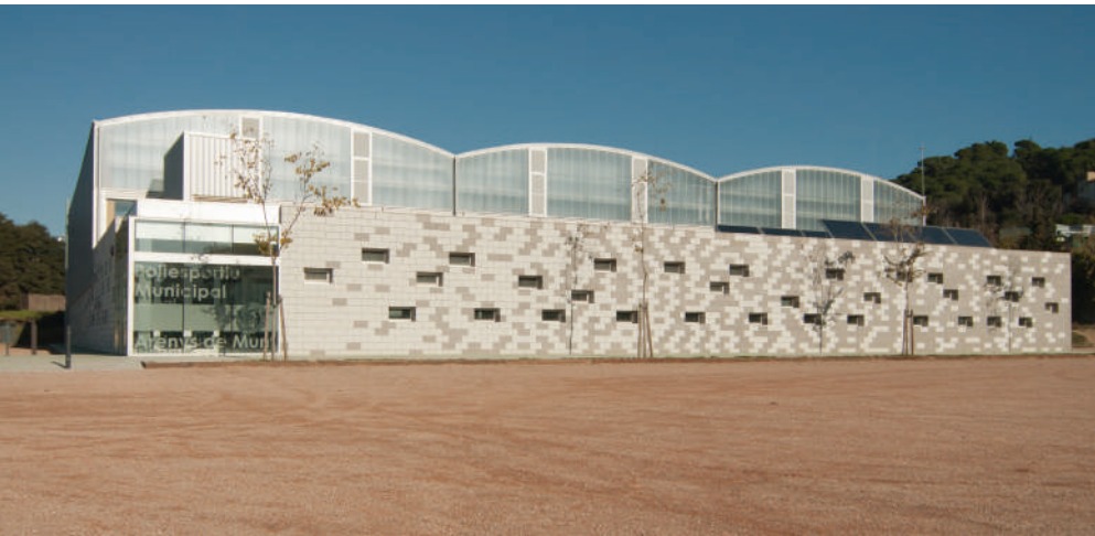
Pabellón polideportivo PAV-3. Arenys de Munt, Barcelona. 2009
