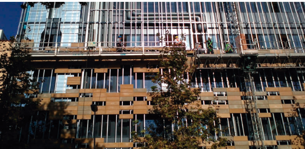
Industria Breinco. Proyecto de innovación de fachada ventilada para ofrecer nuevas prestaciones, nuevas posibilidades compositivas y la integración de componentes arquitectónicos y tecnológicos.
