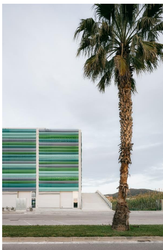
Metal – Edificio Gonsi Sócrates, Barcelona, 2020, Ph. Aldo Amoretti
